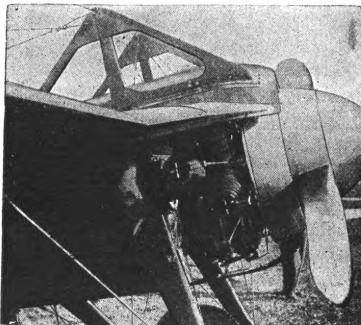
Fig. 16 a. Motoranlage des 160 PS-Deperdussin-Eindeckers.
