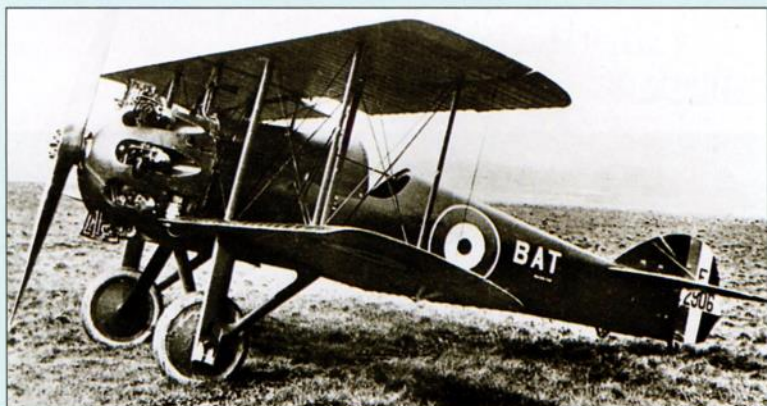
Характерной чертой «Бэнтэма» являлся стационарный радиальный мотор воздушного охлаждения
