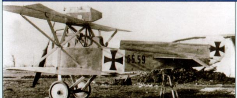
Вверху: «Ганза-Бранденбург» D.I немецкого производства не имели киля - только руль направления. Внизу: вооружение «Ганза-Бранденбург» D.I устанавливалось в характерном «гробике» - надкрыльевом контейнере
