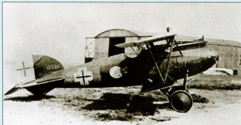
«Альбатрос» D.V получил новый фюзеляж овального сечения, напоминавший по форме вытянутую каплю
