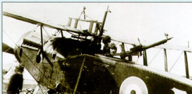
«Бристоль» F.2B, дополнительно вооруженный курсовым «Льюисом» над верхним крылом
