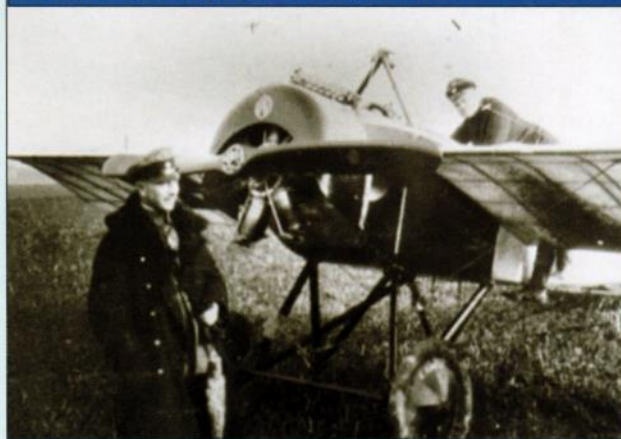
Вооружение «Пфальц» E.I состояло из одного синхронного пулемета «Шпандау»
