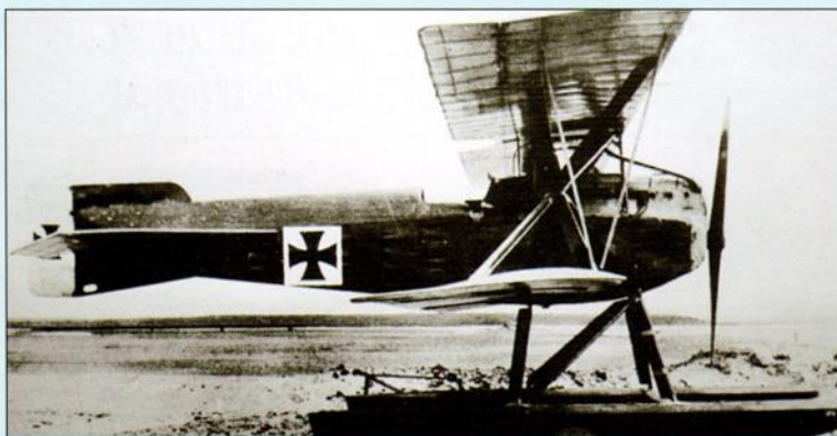
«Бранденбург» KDW отличался «граненым» сечением фюзеляжа и характерными звездообразными межкрыльевыми стойками
