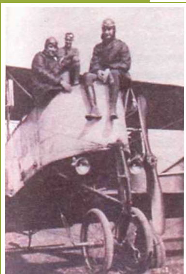
Ночные бомбардировщики оснащались посадочными фарами.
