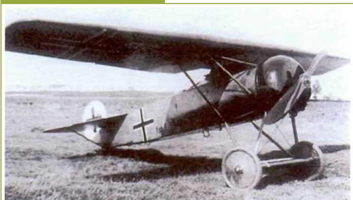
На снимке хорошо виден кабан крепления крыла к фюзеляжу.
