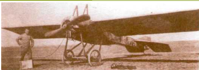
Самолет имел очень прочное шасси со стойками из гнутых труб.
