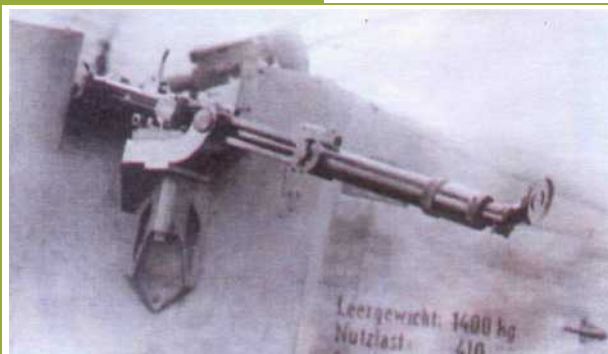
Пушка Беккера устанавливалась на борту самолета на специальном кронштейне и предназначалась для обстрела наземных целей.
