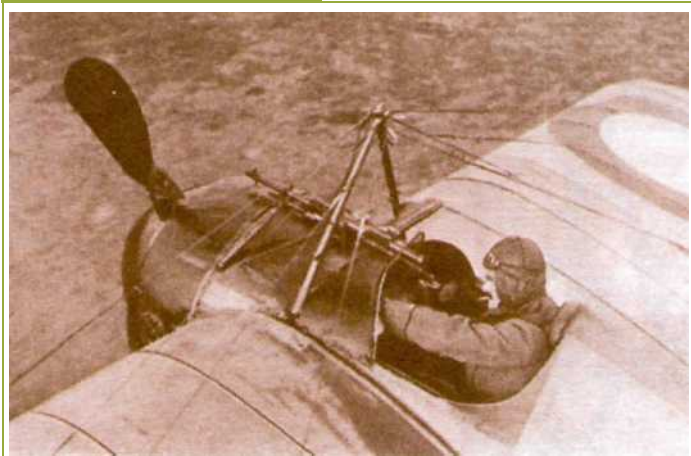
Пулемет «Сент-Этьен», установленный на Моран-Солнье, имел магазинное зарядание.
