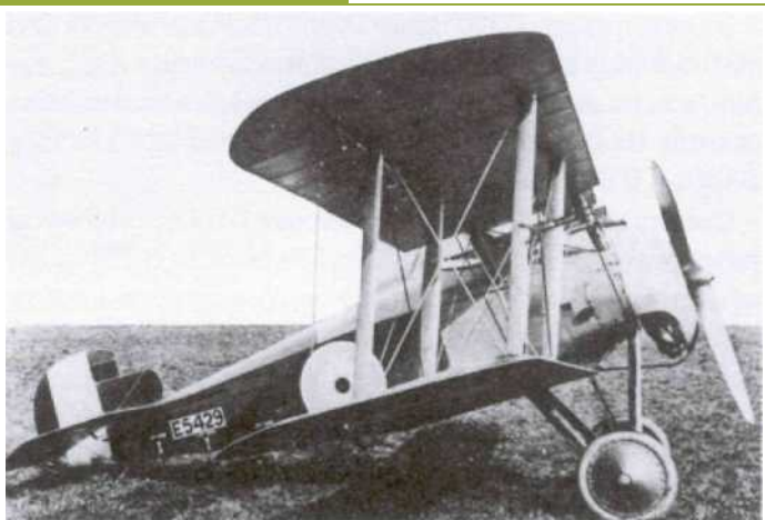
Созданный на основе «Снайпа», внешне TF.2 «Саламандер» отличался плоскими бортами фюзеляжа.
