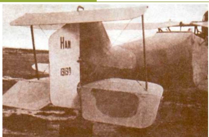
Хвостовая часть CL II. Стальные стойки придавали жесткость коробке стабилизаторов. Оба стабилизатора оснащались рулями высоты, качалки которых размещались в утолщенном киле.
