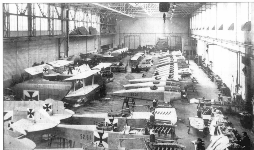
A view of the production hall in February 1917. C.II planes in the forefront, behind them the fuselages of Albatroses of the first production series (53.36 in the middle etc., at the back left 53.06 with wings mounted). Pohled do výrobní haly v únoru 1917. V popředí stroje C.II, za nimi trupy Albatrosů první výrobní série (uprostřed 53.36, atd., vzadu vlevo s křídly 53.06).
