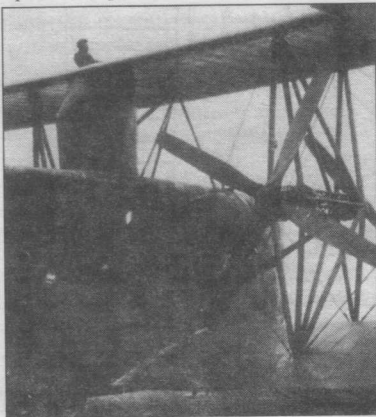
«СШВ R.VIII» № 23/16. Хорошо видны винты между крыльями, радиатор и обтекатель лентки, ведущей на верхнюю огневую точку.
