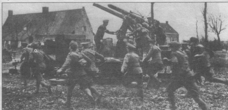
Английская батарея 13-фунтовых зенитных пушек, район Арменшьер, 1915 год. Эти пушки добивали до высоты 5700 м.
