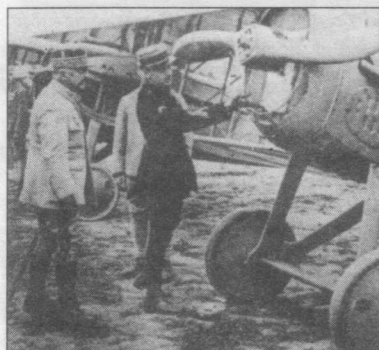
Французский ас Жорж Гинемер объясняет генералу Фрасету д'Эсперей детали самолета «СПАД 12Са». Аэродром Ла-Бон-Мезон, 5 июля 1917 года. Виден ствол 37-мм пушки, торчащий из ступицы винта.
