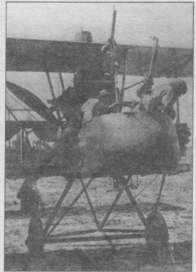
FE.2b из 20-й эскадрильи, 1916 год. Видно вооружение в виде трех пулеметов «Льюис» и четырехлопастный винт.
