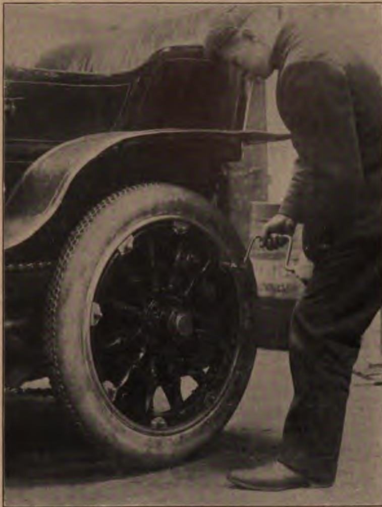
Abb. 123. Anziehen der Muttern mit der Brustleier.
