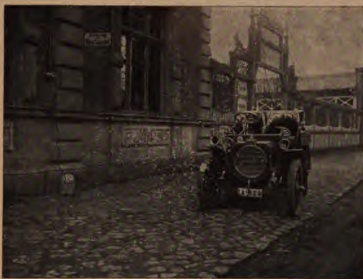
Abb. 127. Vulkanisierung eines Deckendefektes auf der Straße.
