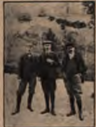
Les 3 Spontons qui ont servi à l'entretien du matériel de la Compagnie des Chemins de Fer de l'Alsace à Mulhouse.
