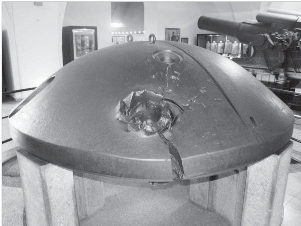
Купол башни одного из фортвов Антверпена, пробитый и расколотый 30,5-см снарядом во время его осады в 1914 г.
