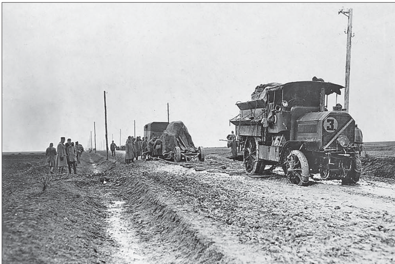
Попытка вытащить увязший в грязи ствол и боезапас 305-мм мортиры при помощи постройки деревянного настила на дороге Бережаны — Подгайцы в Галиции, 1916 г.
