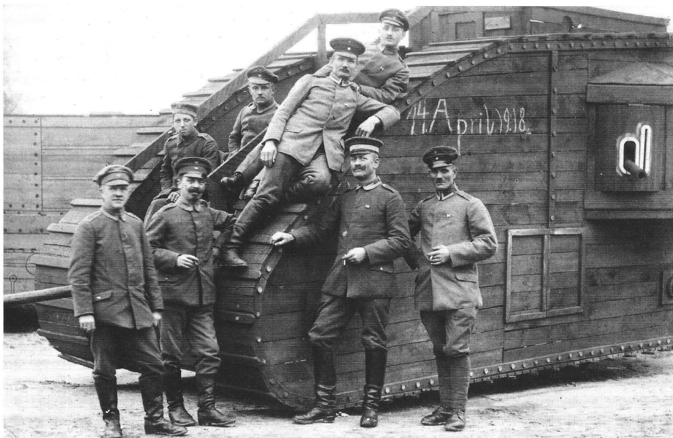
Zwar nur im Detailausschnitt zu sehen, zeigt diese Tankattrappe doch bereits die Luke im seitlichen Heckbereich, wie sie für den Nachfolger des Mk. IV, den Mk. V, typisch war. Auch bei dieser Attrappe handelte es sich um eine Ausführung "Female" mit simulierter MG-Bewaffnung. Only a close-up but this tank dummy shows the typical hatch of the improved Mk. V tank version, the successor of the Mk. IV. This is a Female version with the machine-gun sponsoons. (JV)
