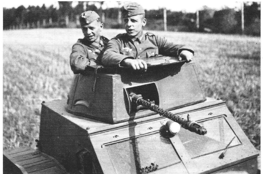
Nahaufnahme des Turmes mit eingebautem 7,92 mm Maschinengewehr MG 34. Man beachte auch die Maschendraht-Verstärkung der Windschutzscheiben und den Scheibenwischer.
