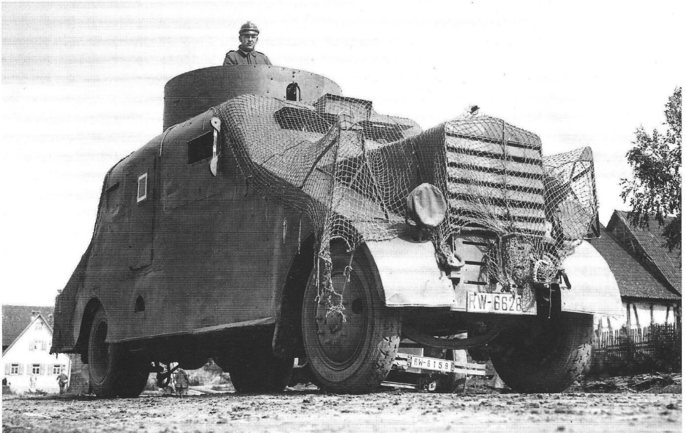
Eine der ersten Panzerattrappen der Reichswehr war auch die größte motorisierte Attrappe der deutschen Heere: die Büssing-Panzerattrappe von 1926. Sie war in den Abmessungen und im taktischen Einsatz immer noch tief in den Erfahrungen des 1. Weltkrieges verwurzelt. One of the first Reichswehr dummy tanks was the Büssing-Panzerattrappe of 1926. It would also remain the biggest Panzerattrappe ever built for the German armies. Its dimensions and tactical use were still deeply rooted inside the experiences of World War One. (HH)
