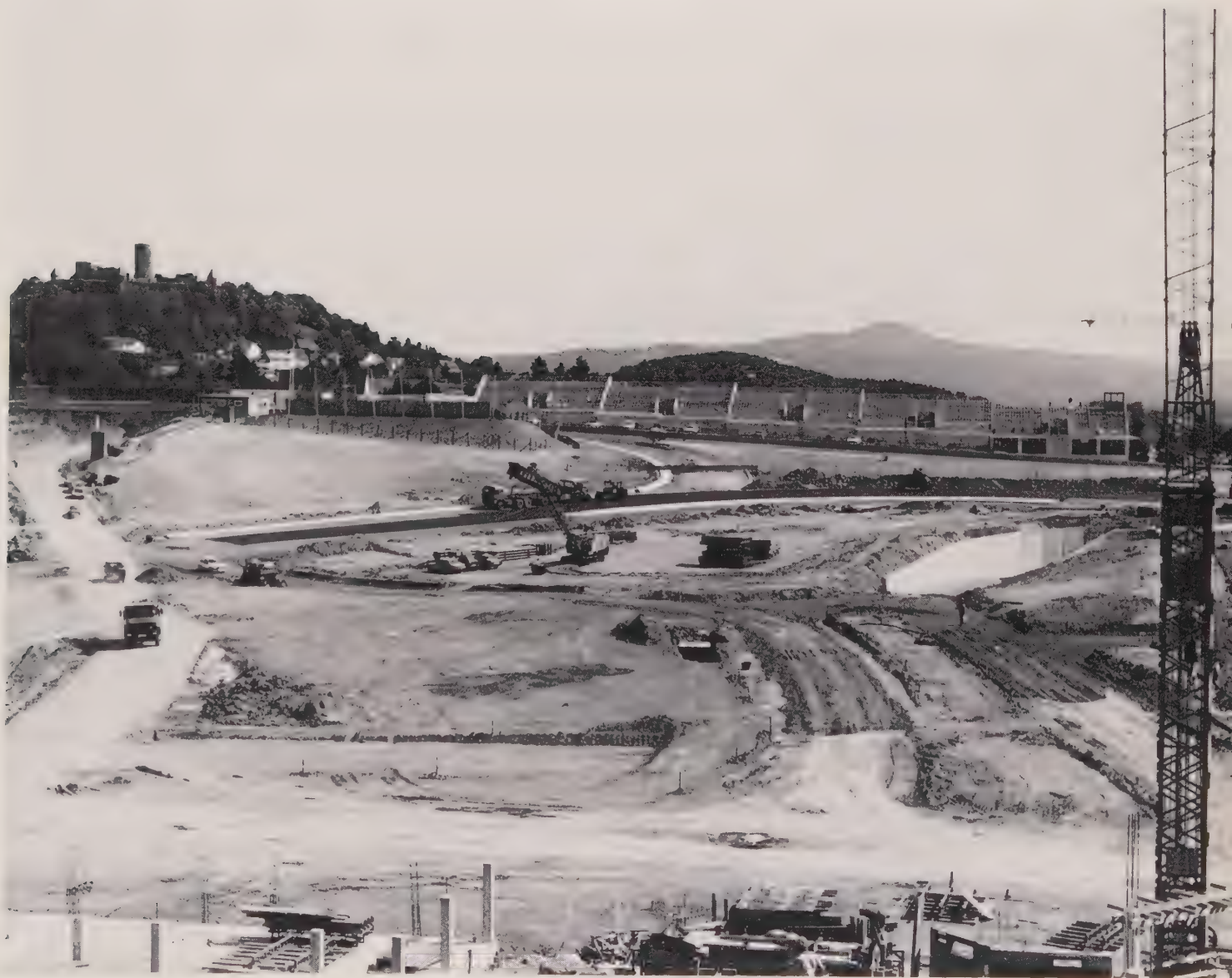
Der nördliche Bereich der Baustelle im Juli 1983.
