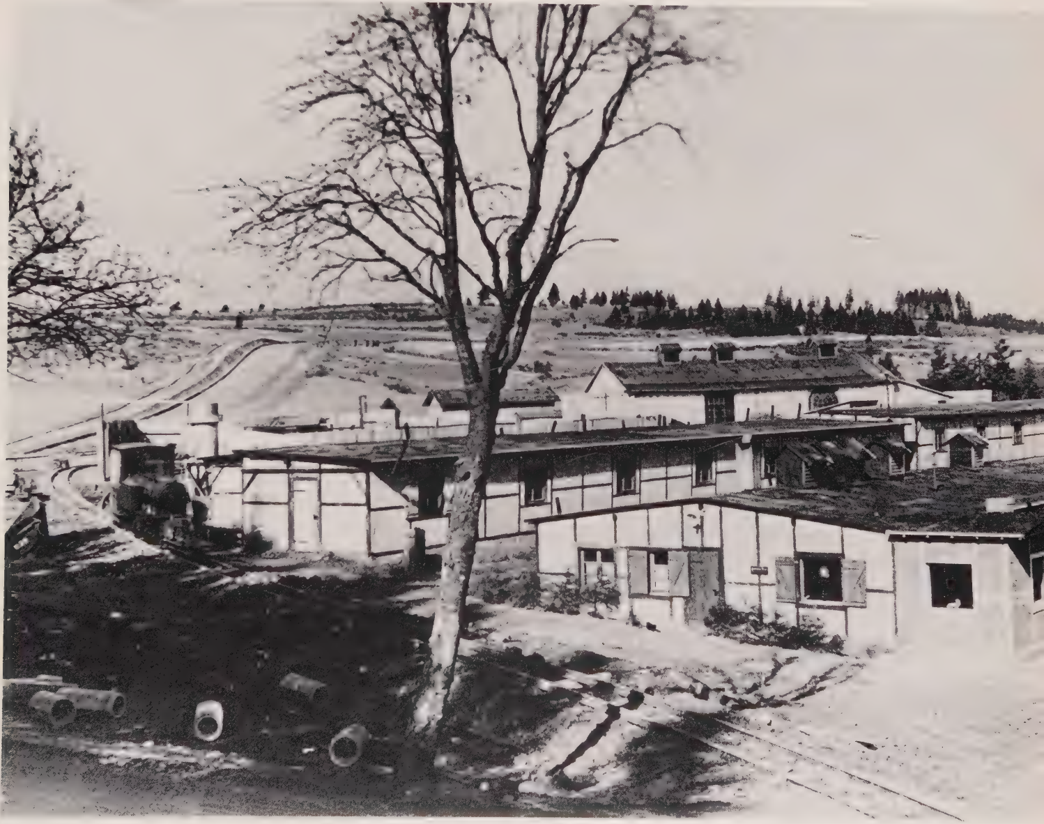
Während der Bauphase wohnten die Arbeiter in Baulagern wie diesem auf der Quiddelbacher Höhe.
