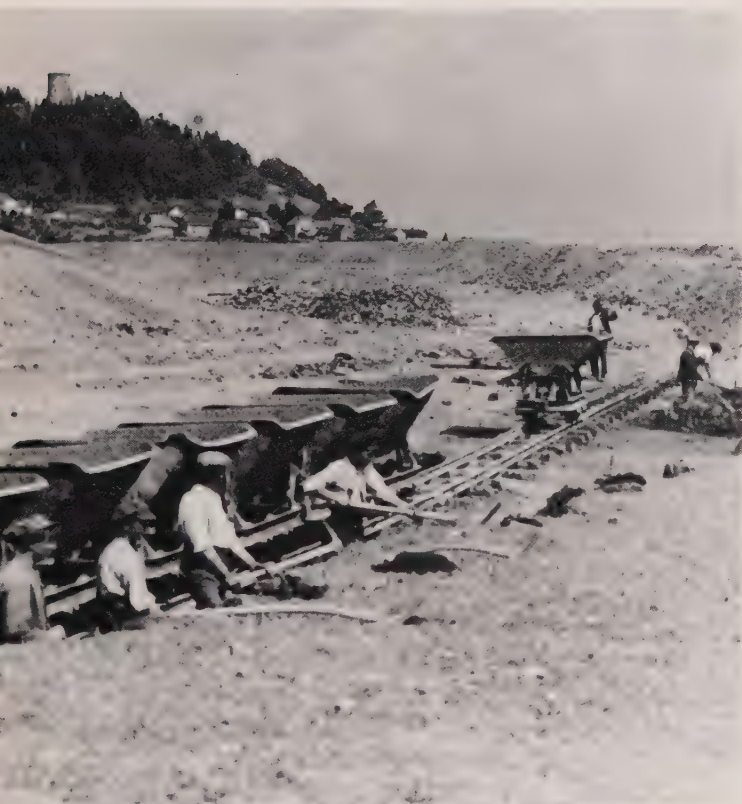
Hacke und Schaufel waren die wichtigsten Hilfsmittel der Arbeiter beim Bau des Nürburgrings von 1925 bis 1927. Hier wird die Nordkehre angelegt.
