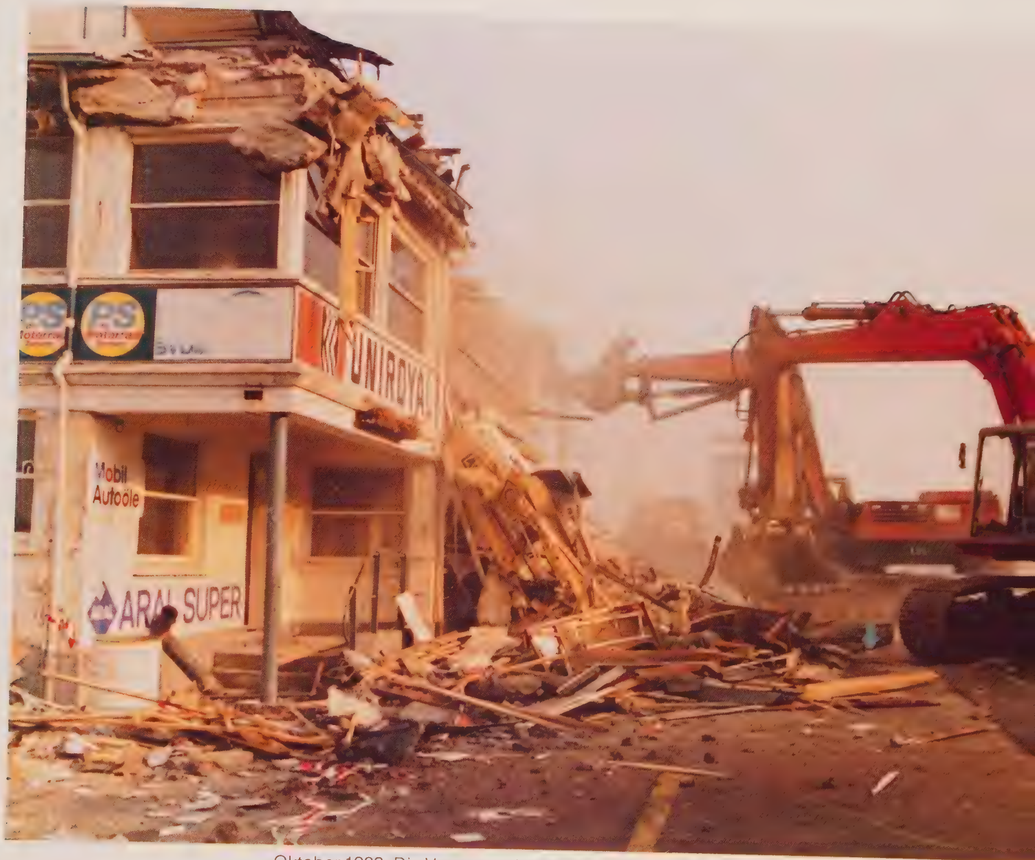
Oktober 1982: Die Vergangenheit muß der Zukunft Platz machen. Abbrucharbeiten im Boxenbereich.
