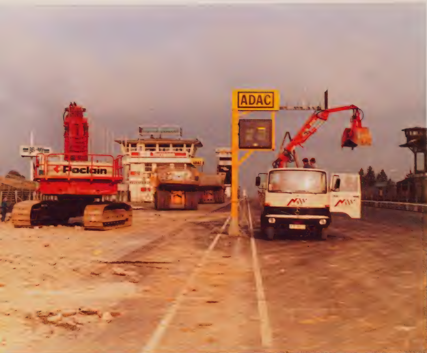
Das alte Start- und Zielgebäude, Stätte von Geschichte und Geschichten, versinkt in Schutt und Staub.
