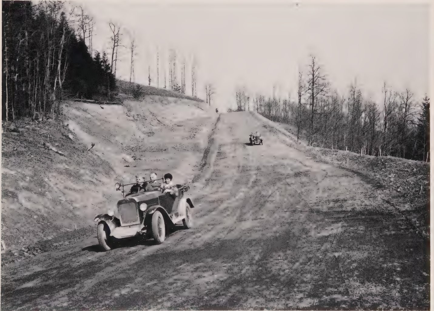
Die Rennstrecke war noch nicht fertig, doch vor Caracciola und Merz machten Motorsportenthusiasten wie der Nürburgring-Mitinitiator Hans Weidenbrück ihre Probefahrten. Das Bild zeigt die „Fuchsröhre“ im Rohbau.
