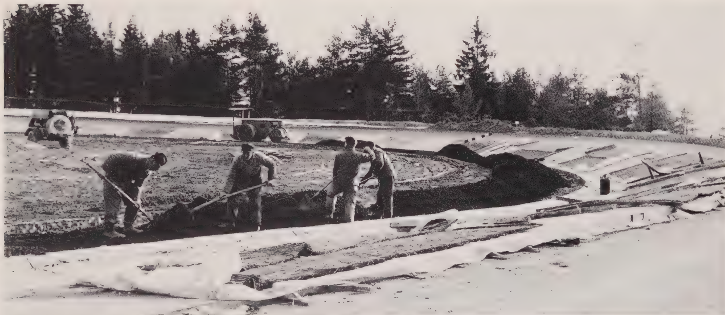
Umbau des Karussells. Der Bogen wird weiter, die Innenwand flacher.
