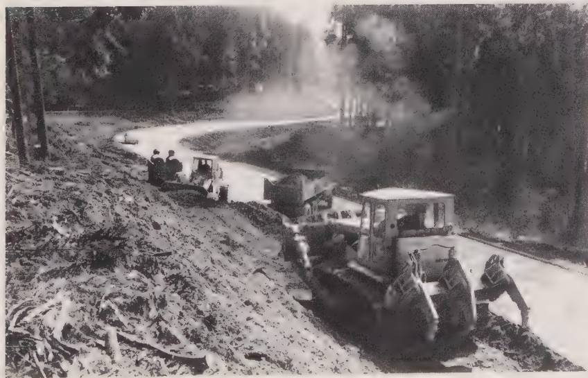
Im März 1971 regieren die Baufahrzeuge auf der Nordschleife.
