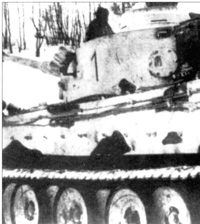
Белая краска с танка «Тигр» (бортовой номер «1») сильно облезла. Кормовой башенный контейнер Rommelkiste окрашен в серый цвет.
