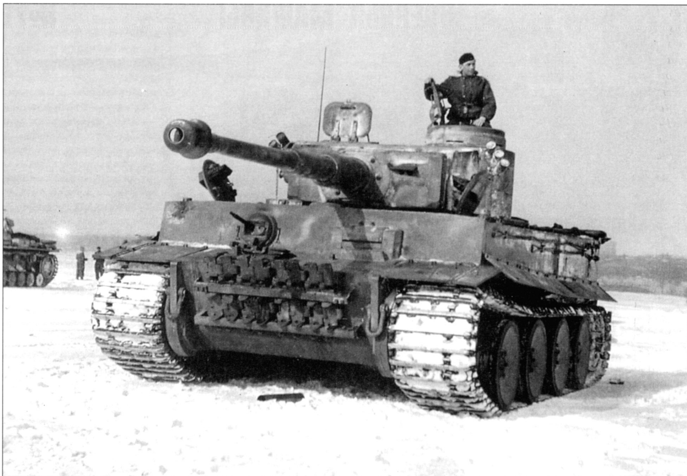
Танк Pz.Kpfw. VI Tiger Ausf. H1 раннего выпуска. Это «Тигр» гауптмана Ланге, командира 3-й роты 503-го тяжелого танкового батальона, зима 1943-1944 г.г., Россия. Нетипично крепление запасных траков на лобовом бронелисте корпуса - две параллельные балки. Над отверстиями в маске пушки под оптический прицел наварен козырек.
