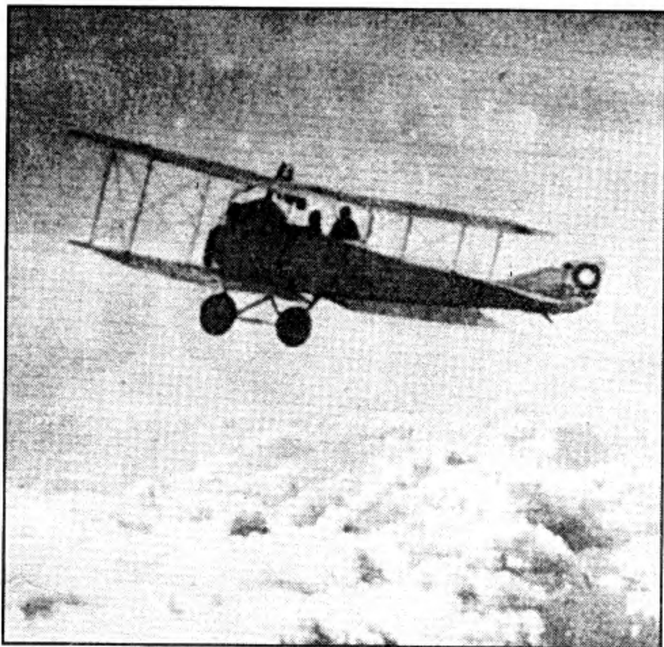
Цельнодеревянный биплан «Альбатрос» В.11 конструкции Эрнста Хейнкеля.
