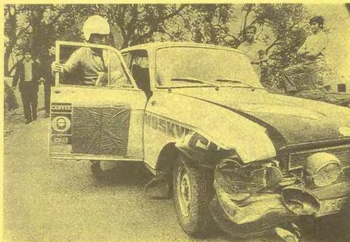
▲ Этот гоночный автомобиль «Москвич-Г5М» конструкции И. Гладилина сейчас можно увидеть в музее АЗЛК. Формулу отличали алюминиевый кузов, трубчатая рама, форсированный двигатель «412» с двумя распределителями и пятиступенчатой коробкой передач в блоке с редуктором, карбюраторы «Вебер». Это последний и, кстати, победный старт В. Щавелева на Кубке Прибалтики в 1970 году.
