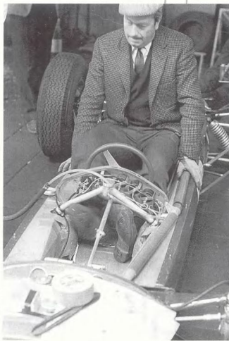
Исторический момент: Коллин Чармен пробует только что построенный монокок Lotus 25
