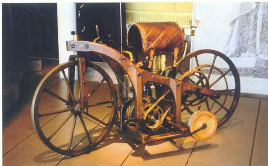
...и первый мотоцикл планеты, собранный Готлибом Даймлером и Вильгельмом Майбахом в конце 1885 года
