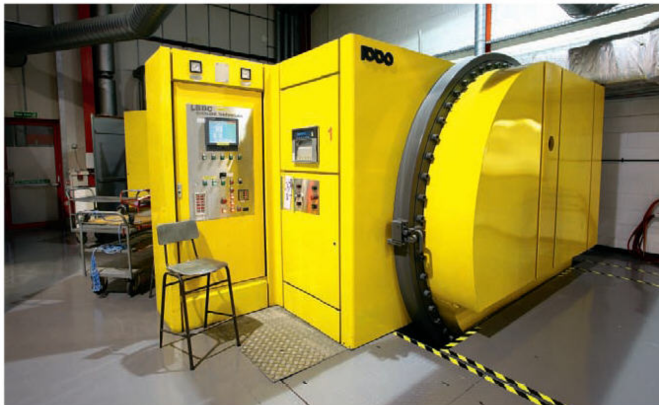
Si l'autoclave semble abandonné, c'est parce que tout le monde est ailleurs en train de finir l'usine elle-même pour pouvoir travailler !
