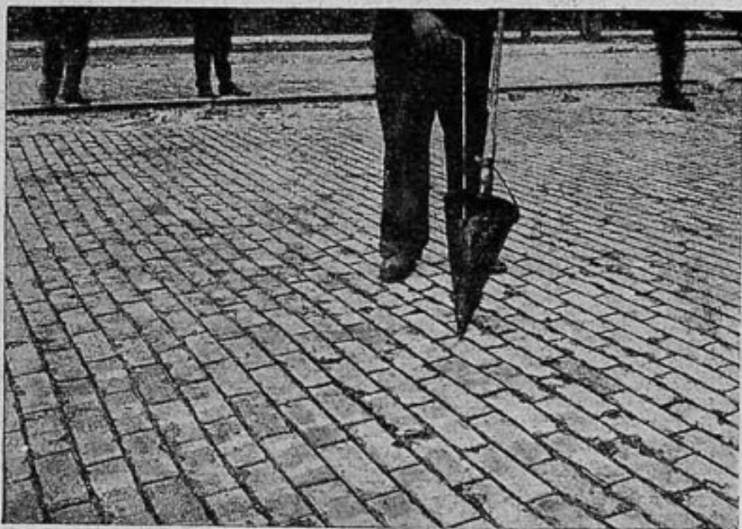
Заливка швов битумом
