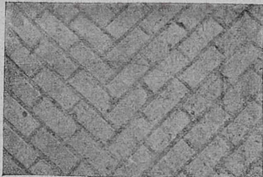
Еид клинкерной дороги со швами заполненными битумом
