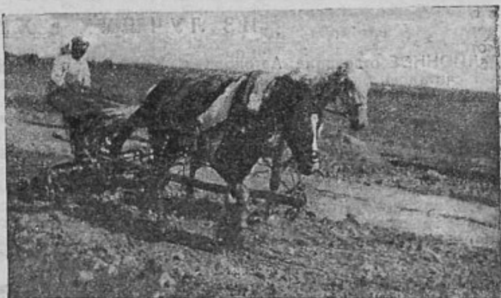
С дисковой бороной на дорожных работах (предварительное разрыхление)
