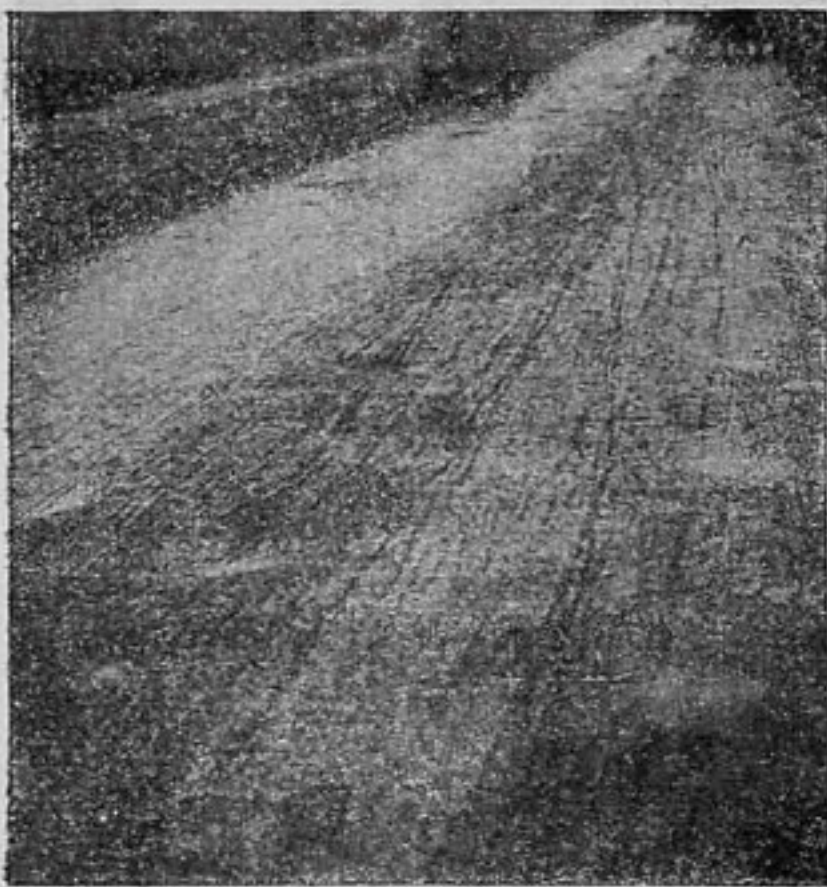
Выстроенная в прошлом году асфальтовая мостовая (1-я Гражданская) сгорбилась и создает при проезде «морскую качку»
