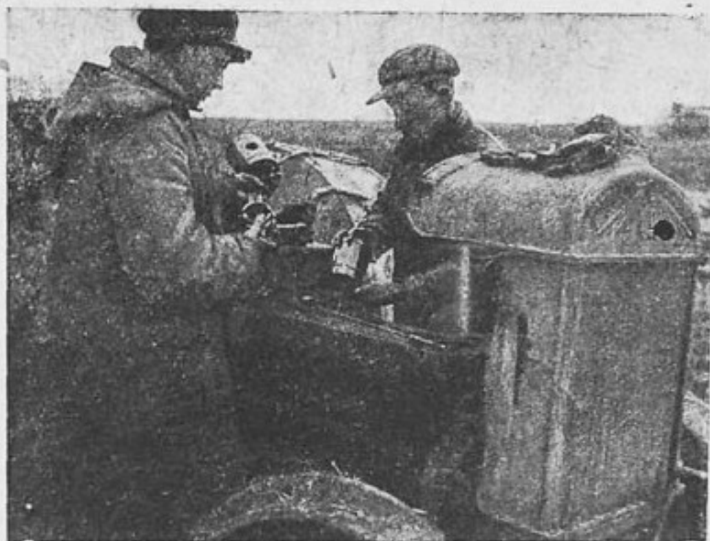
За ремонтом трактора (совхоз Колпино)
