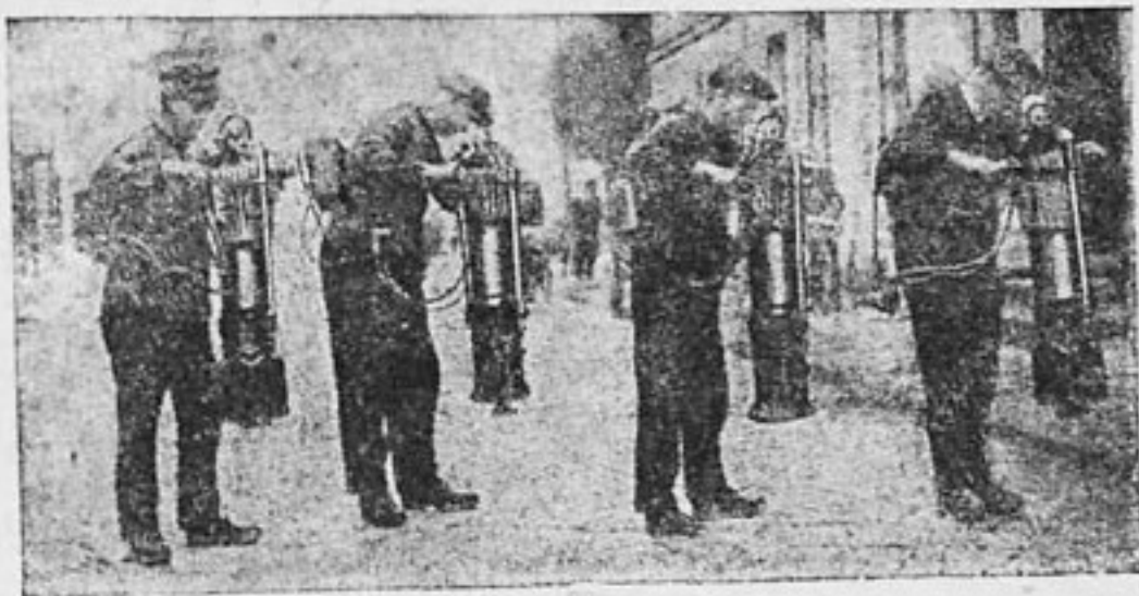
Новые трамбовки внутреннего сгорания в действии
