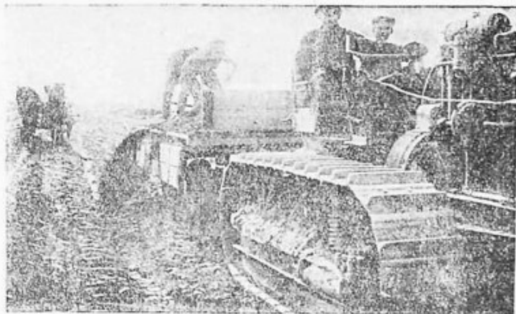
Улучшение грунтовых дорог гравием. Засыпка колеи
