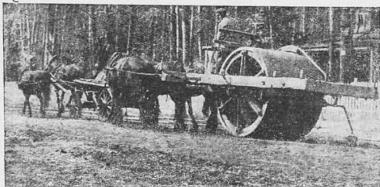
Окончательная укатка отремонтированного шоссе конным ратком
