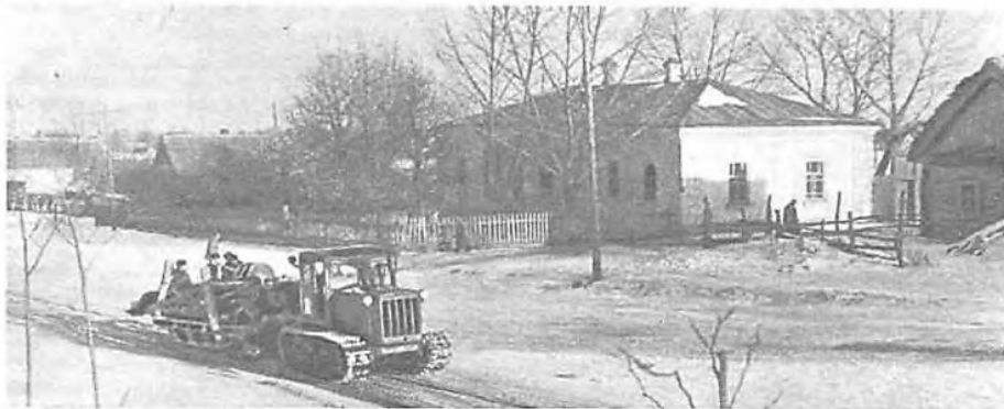
Большинство работ в колхозе «Ленинец» механизировано. Этот гусеничный трактор везет стройматериалы на животноводческую ферму.
