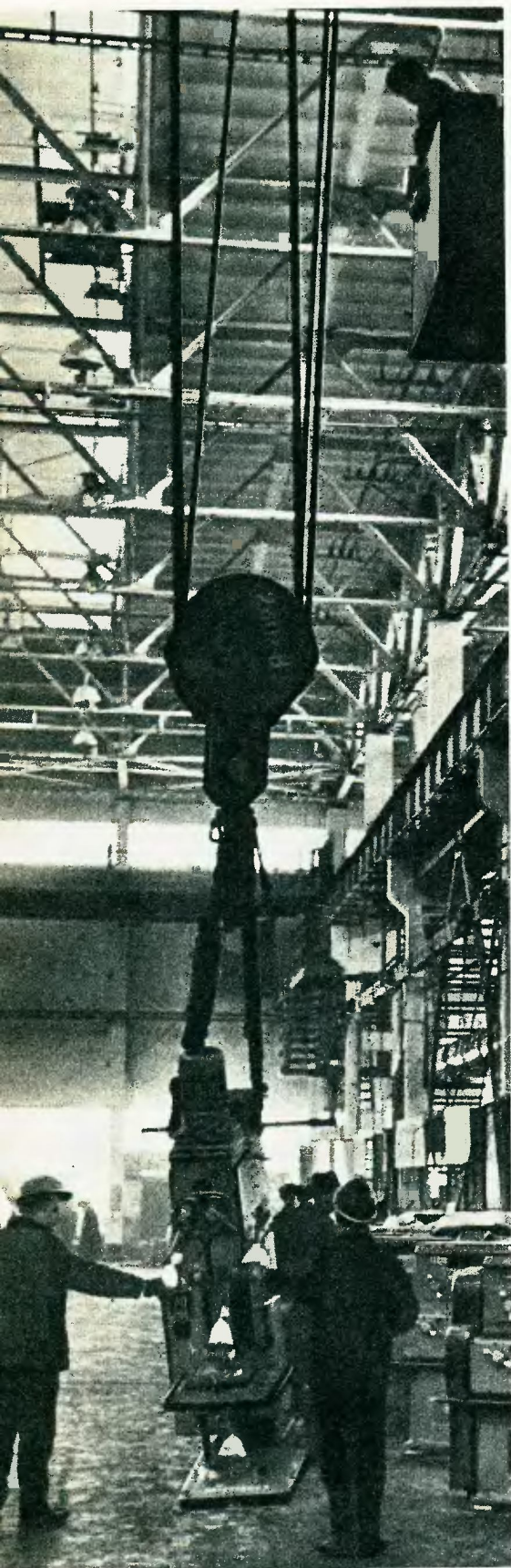
На РИЗе идет монтаж оборудования. Март 1973 года.
