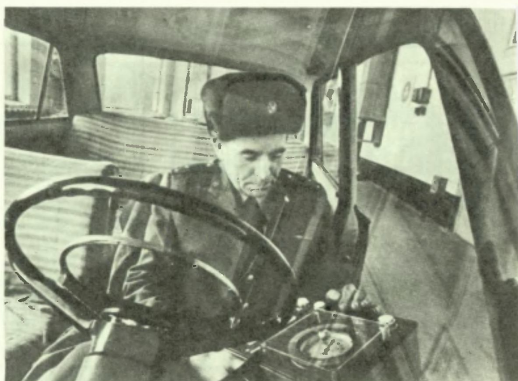
Проверка эффективности торможения.
