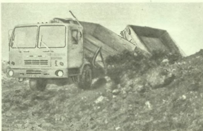
Транспортно-технологический автопоезд сельскохозяйственно-го назначения, разработанный специалистами НАМИ.
