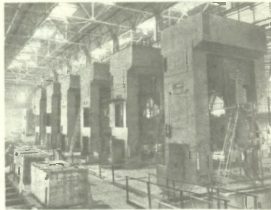
Монтируется автоматическая прессовая линия «Эрфурт» (ГДР) в строящемся прессовом корпусе.
